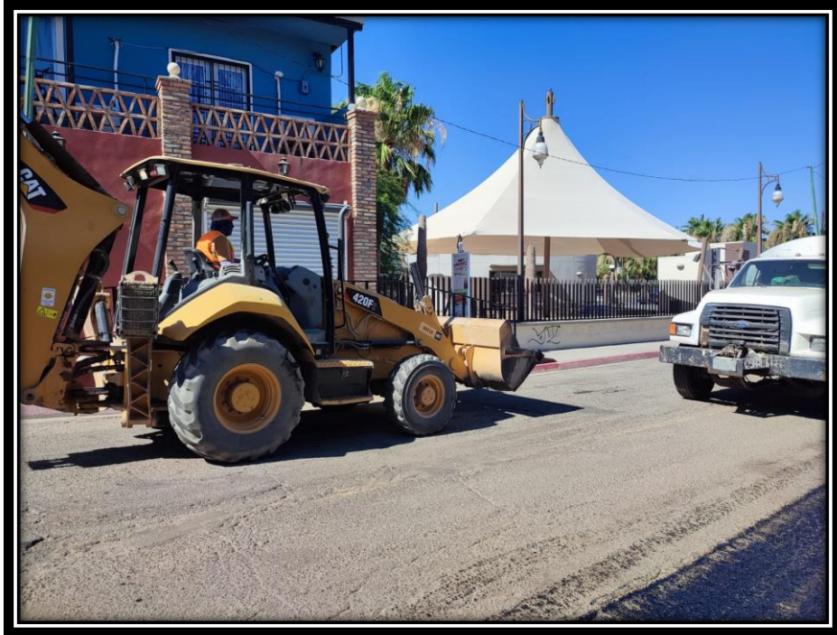
Supervisión de obra FAIS Rehabilitación de calle Saratoga de Av. Internacional a carretera estatal no. 2 , poblado algodones B.C.
