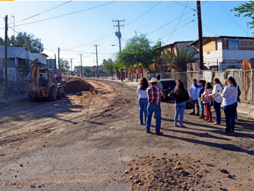
Inspección física de la pavimentación de calle San Carlos en Col. San Isidro, Mexicali, B.C.
