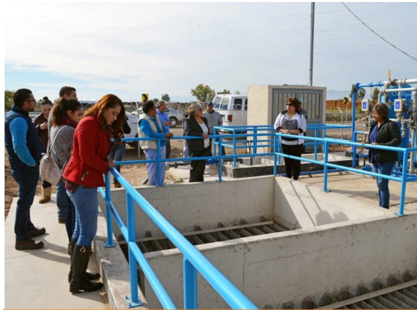
Inspección física de la Rehabilitación del sistema de agua potable en el ejido Jalisco, Delegación Hechicera, Mexicali, B.C.
